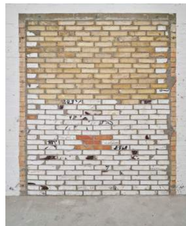
zugemauert mit alten Steinen
