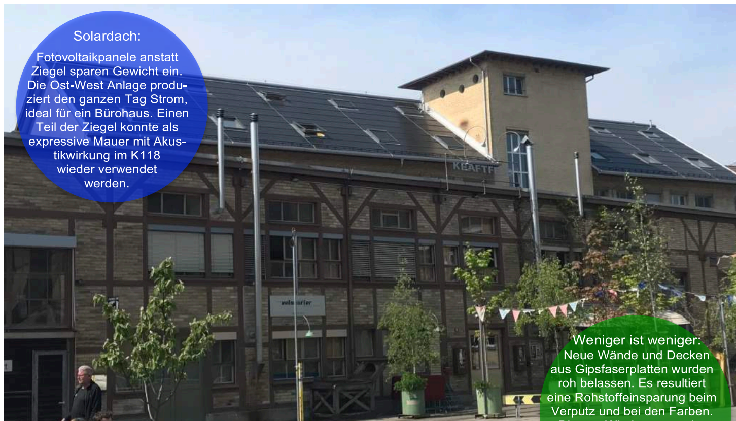
Oben: Ostseite Solardach mit neuen grossen Dachfenstern
