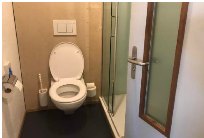
Alles Alt! Von links nach rechts: Klorollenhalter, Hygienesäckklimpender, Beselbehältnis, WC mit UP-Spülkasten, Reserverollenhalter, Duschenwanne mit Kabine und Nasszellentür.
