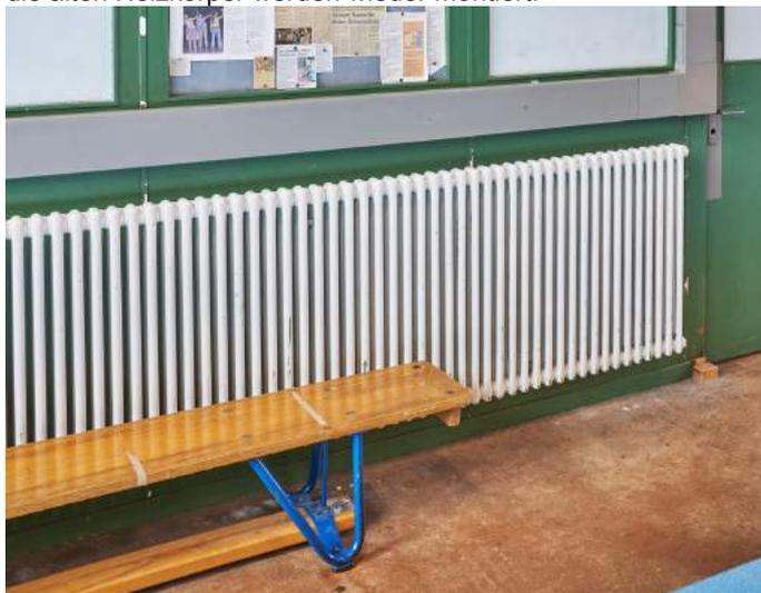
Anstelle des lärmigen Heizgebläses werden die, dank guter Dämmung übrig gebliebenen, Heizkörper der Garderobe in der Halle montiert.
