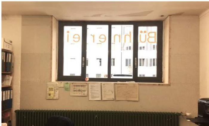
Die Innendämmung ist an der breiten Fensterleibung ablesbar, die alten Heizkörper werden wieder montiert.
